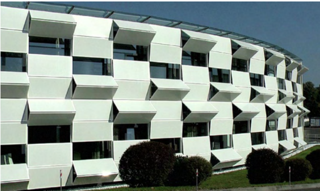
Kiefer Technic Showroom (Autriche) Façade dynamique et automatique
