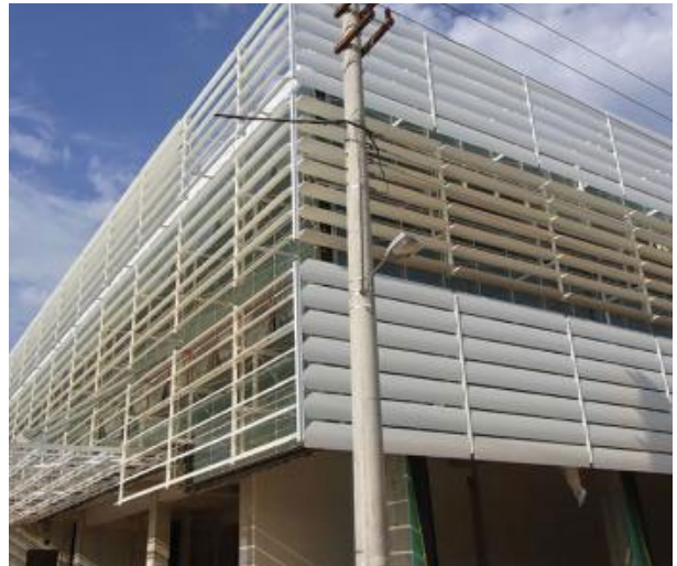
Système de persiennes mobiles automatiques en aluminium (par la firme allemande GLASSCON)
