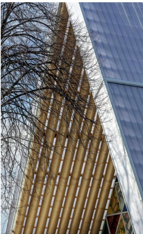
L'un de ses projets les plus emblématiques est la Paper House. Par sa structure porteuse en carton. Bon marché, léger, de taille variable, produit à partir du papier recyclé, le carton n'avait encore jamais été utilisé dans la construction.
