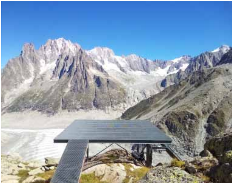
Refuge du requin / plateforme pour hélicoptère Photo A.A.A
