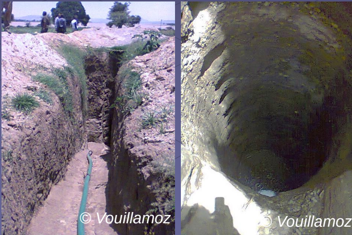
Puits défaillant : pas assez d'eau au regard de la demande, puits asséché...
